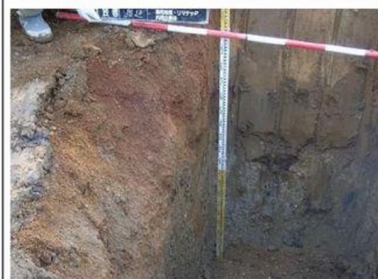
5-⑦-キ-c 確認日：2010/12/9 立会者：監理JV渡辺 掘削深度：1.50m 廃棄物：なし 地質：
