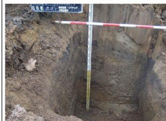
5-⑦-キ-d 確認日：2010/12/9 立会者：監理JV渡辺 掘削深度：1.50m 廃棄物：なし 地質：
