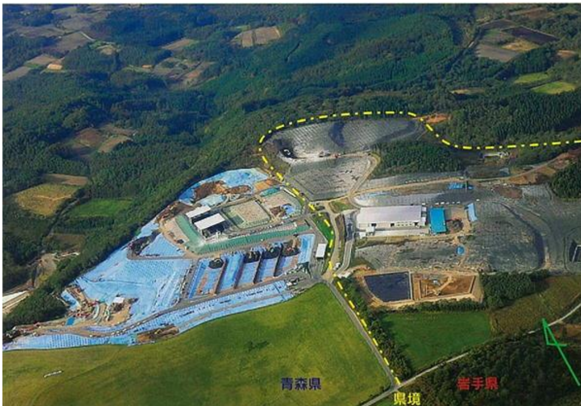
場内キャッピングシートの敷設状況
