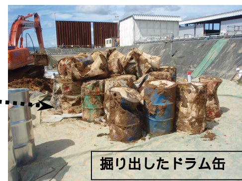
図1 ドラム缶の埋設場所及び撤去状況
