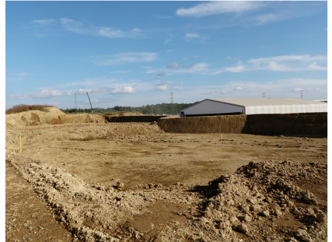
F地区現況(完了全景)
