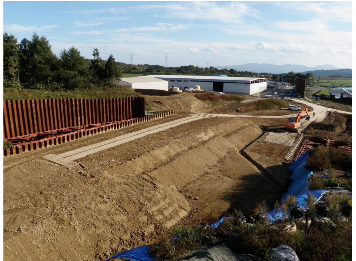
D地区施工状況
