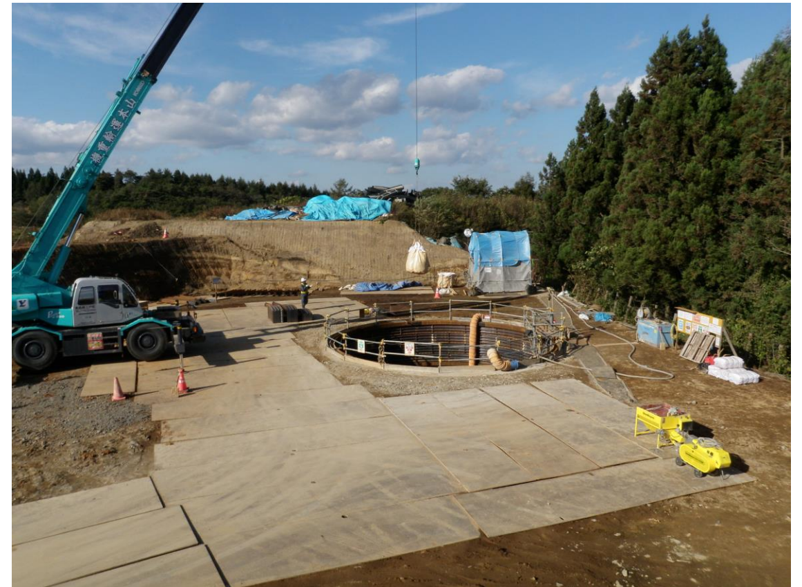
深礎工(水銀汚染土)
