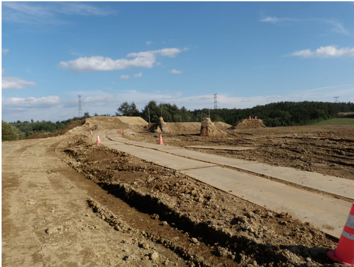
J地区現況(完了全景)
