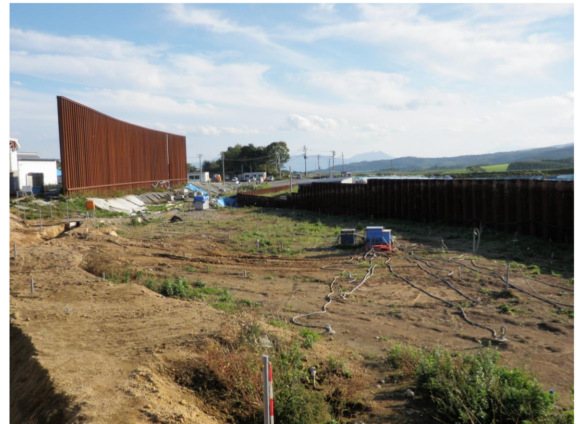
K地区施工状況
