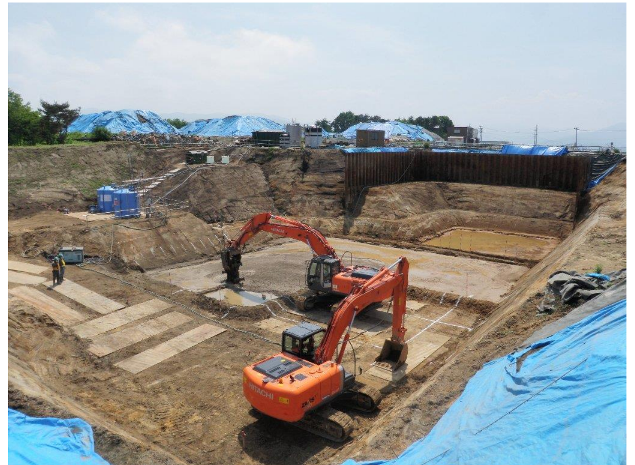
O地区施工状況
