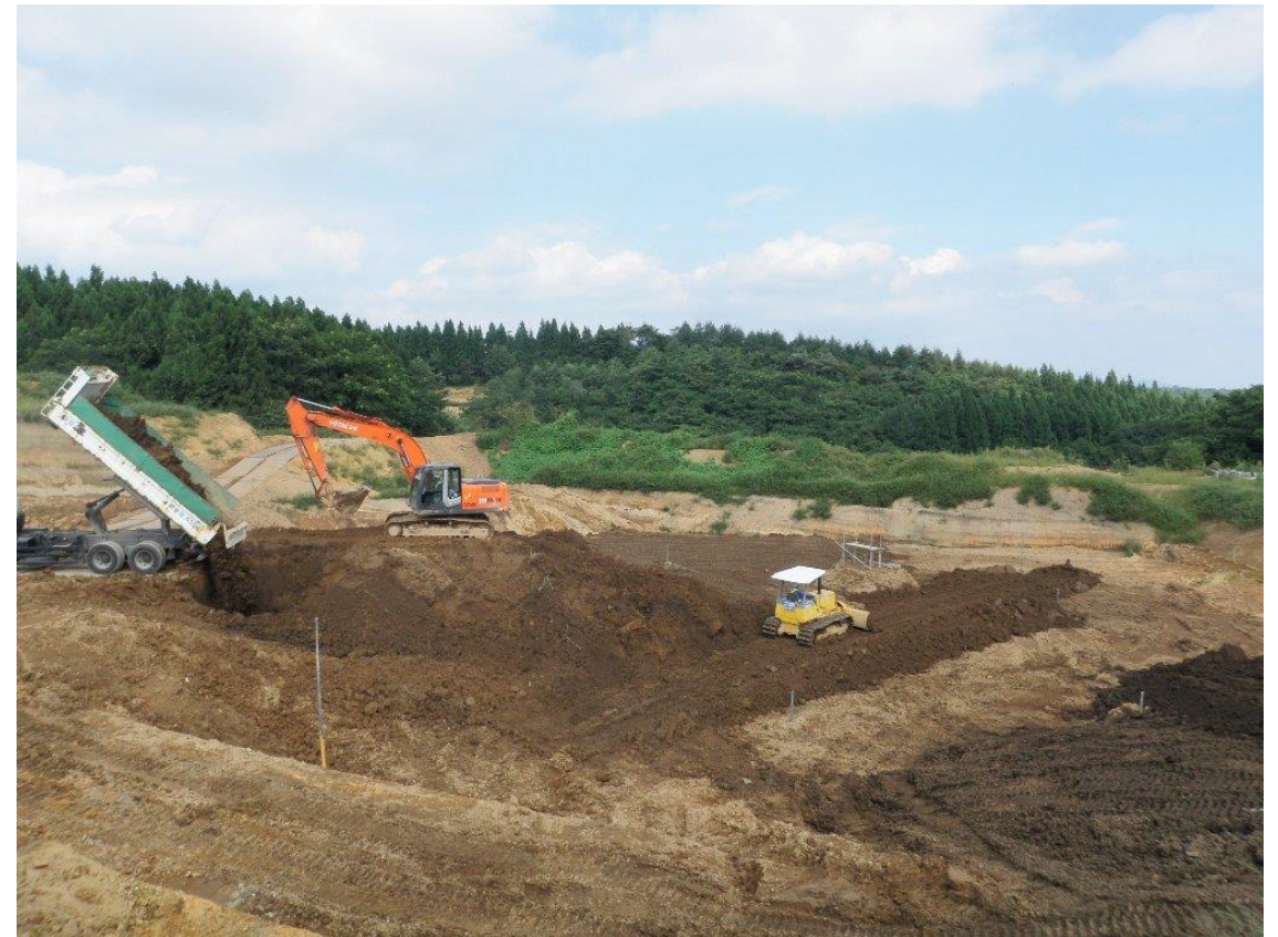
G地区施工状況
