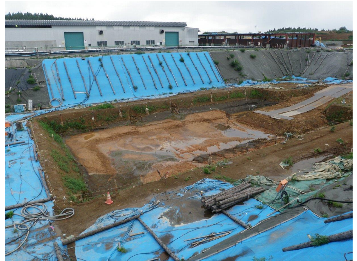
N地区施工完了後
