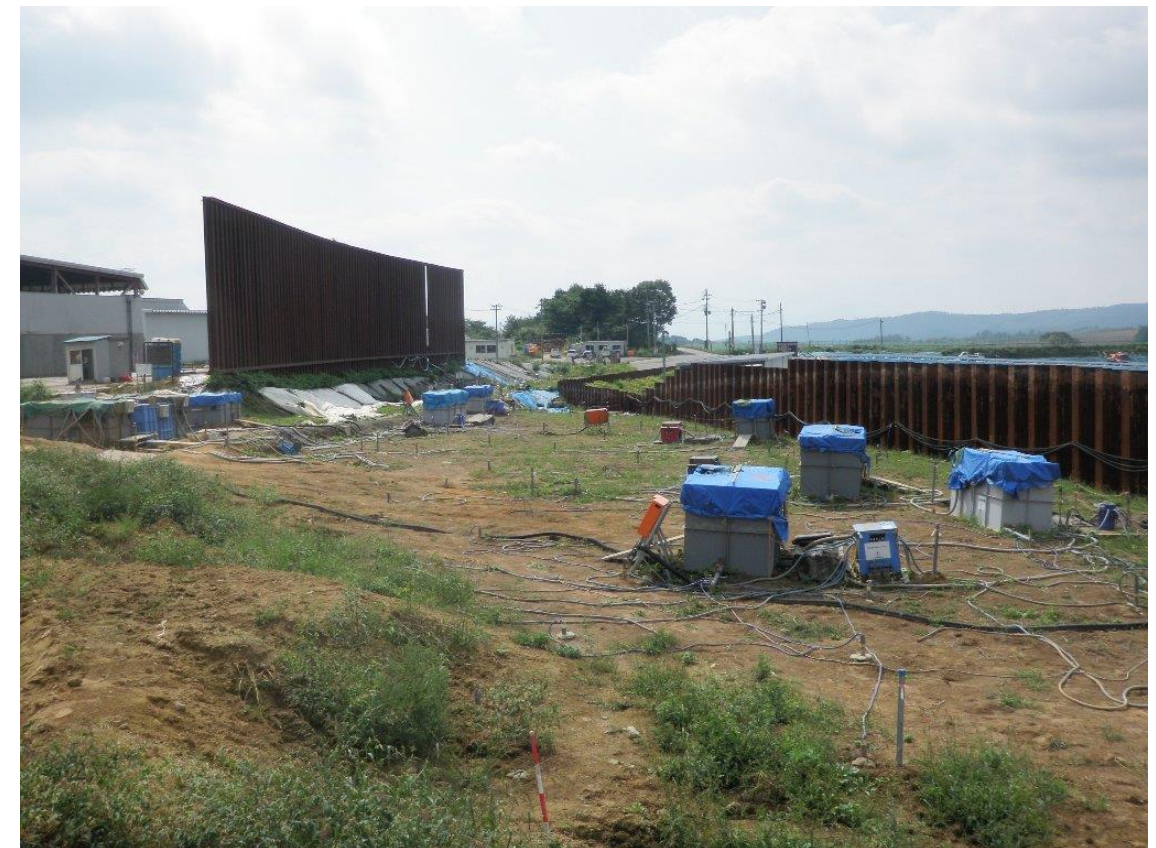
K地区施工状況
