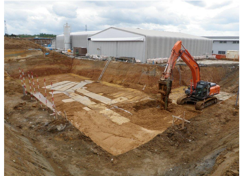
F地区施工状況(機械攪拌施工中)
