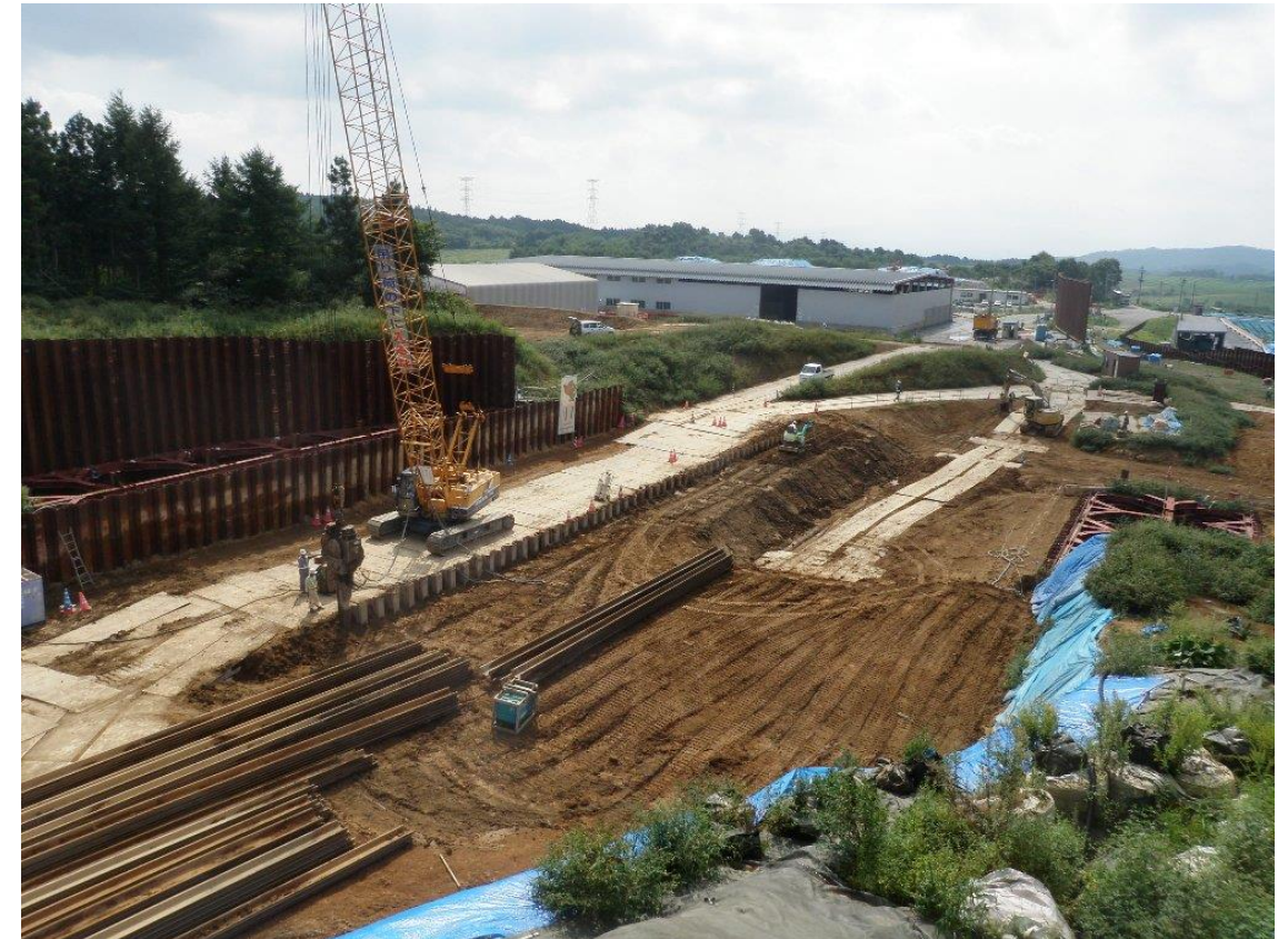
D地区施工状況(VOC高濃度汚染範囲)
