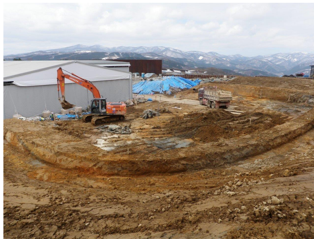
F地区施工状況
