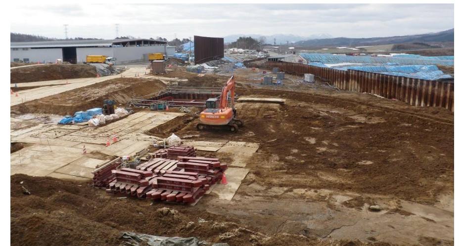
D地区施工状況(重金属範囲)
