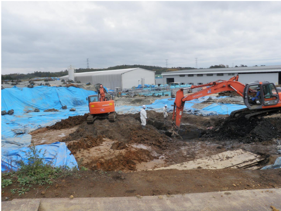
F地区施工状況
