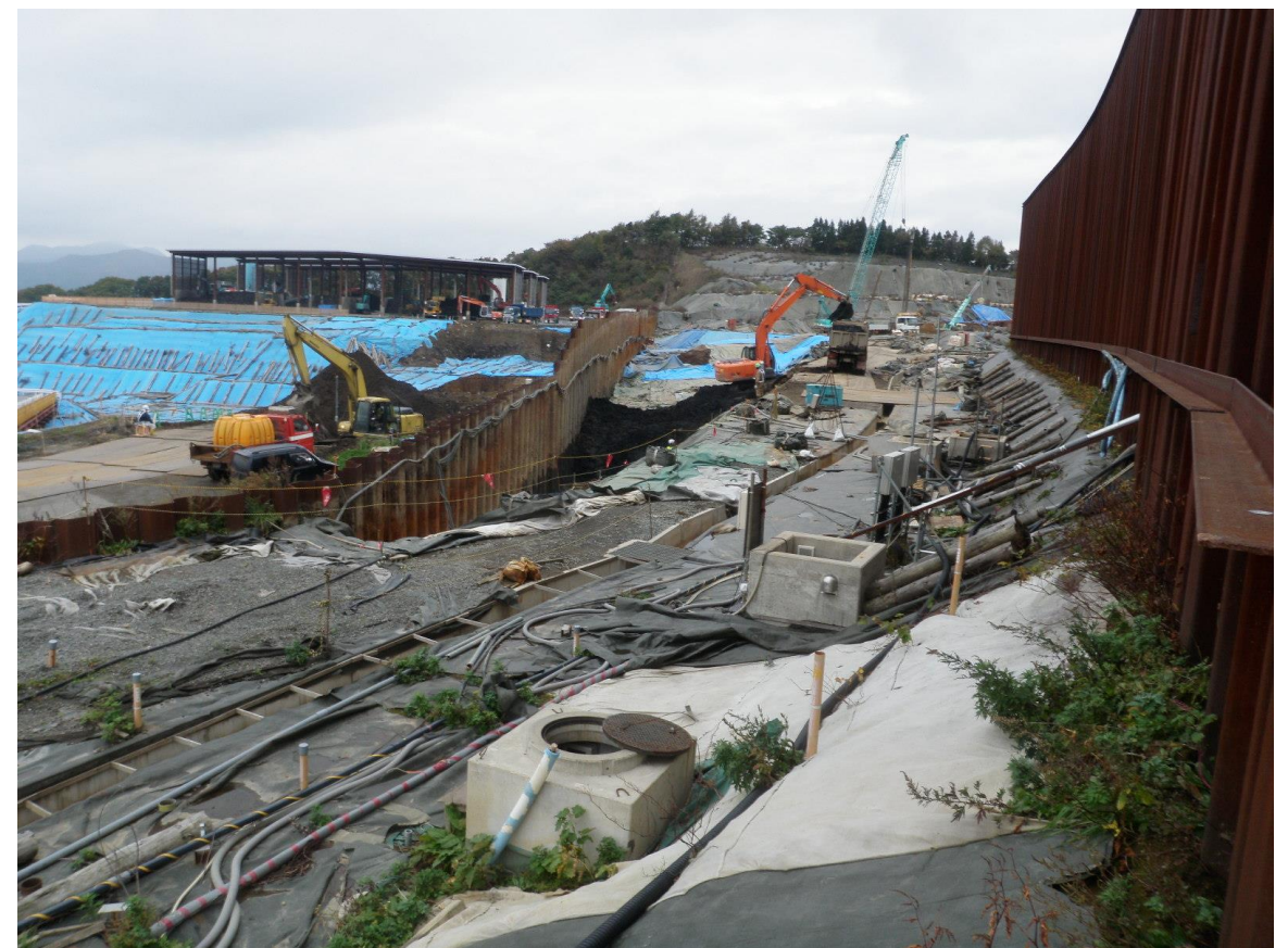
K地区施工状況
