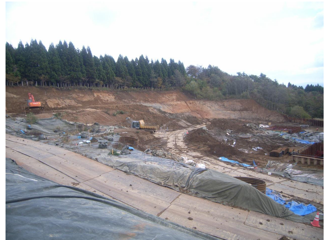
B地区施工状況
