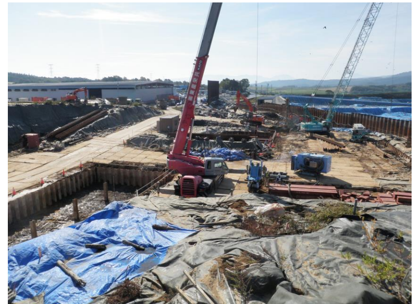
D地区施工状況（重金属範囲）
