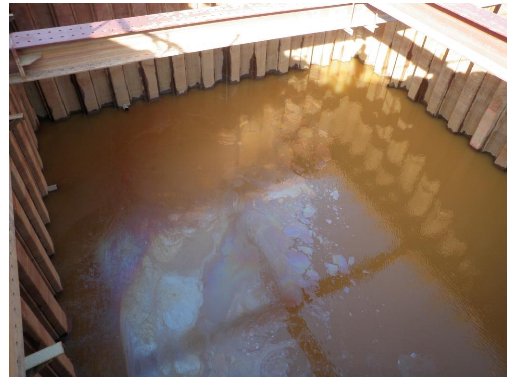
立坑釜場 (4-⑧-キ)
