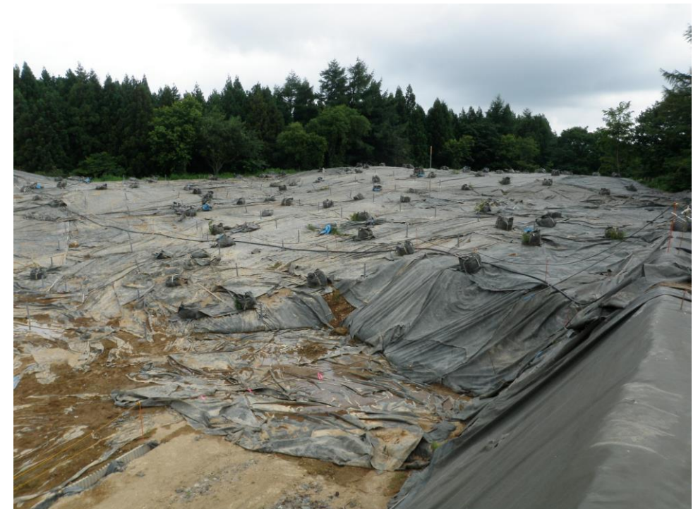
J地区バイオ注入完了
