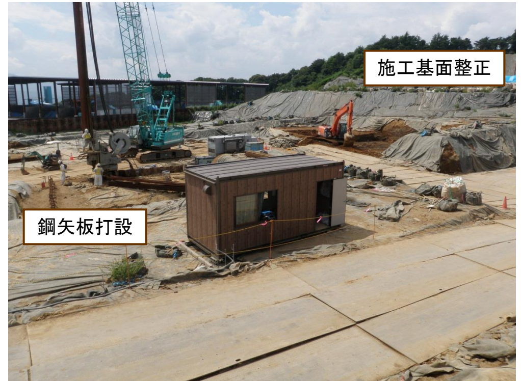
D地区重金属部(基面整正・鋼矢板打設)
