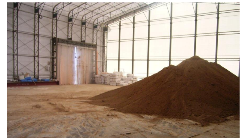
石灰混合土養生
