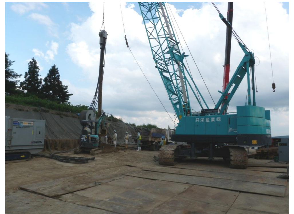
D地区VOC高濃度汚染部(基面整正・鋼矢板打設)
