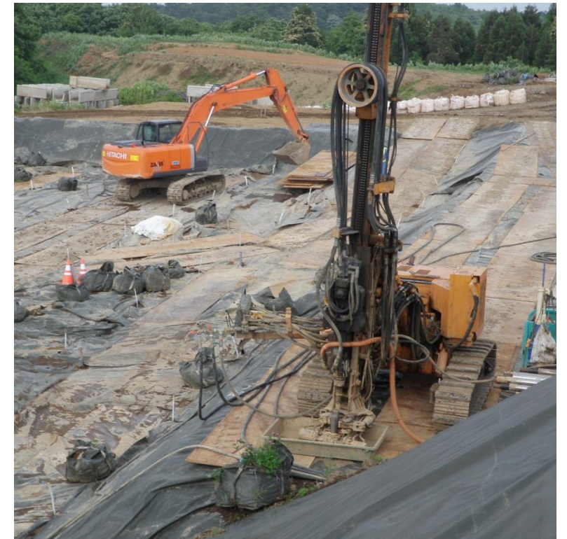
G地区注入井戸設置
