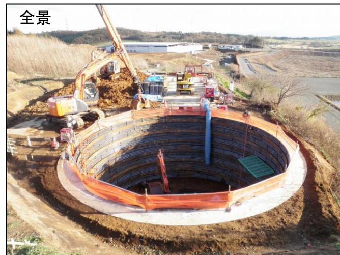
図 3-7 A 地区西側：汚染土掘削除去工状況
