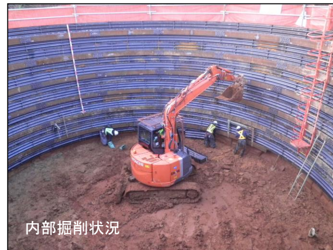
図 3-7 A 地区西側：汚染土掘削除去工状況
