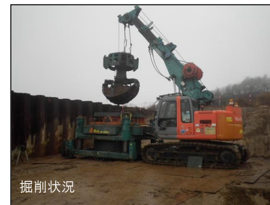
図 3-15 D 地区大型集水井戸（1～5 号）状況写真
