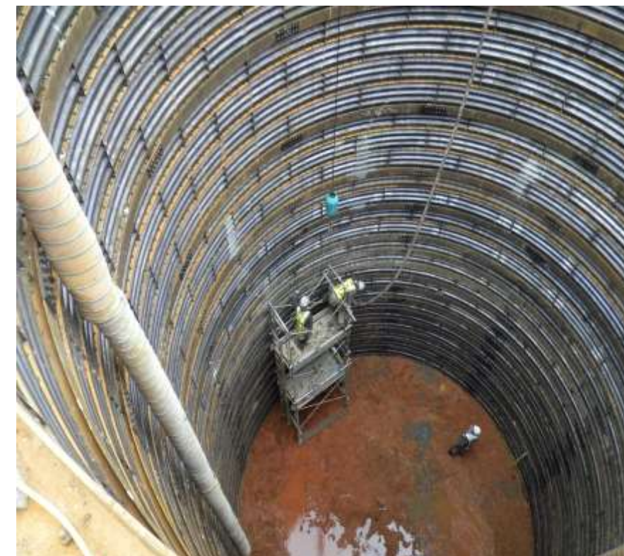
図-20 J 地区既設ライナープレート設置状況
