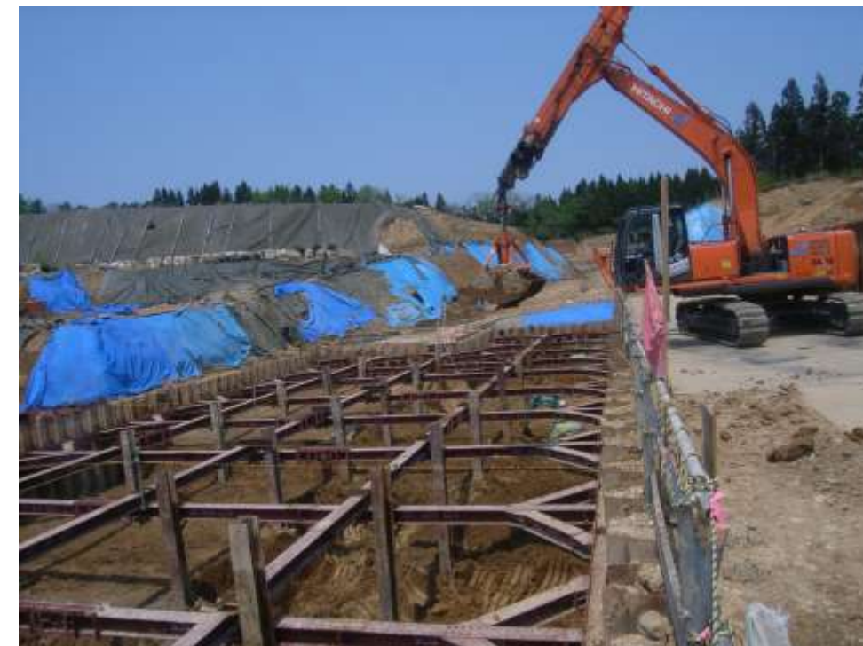
図-10 D 地区での土留め掘削除去工実施例
