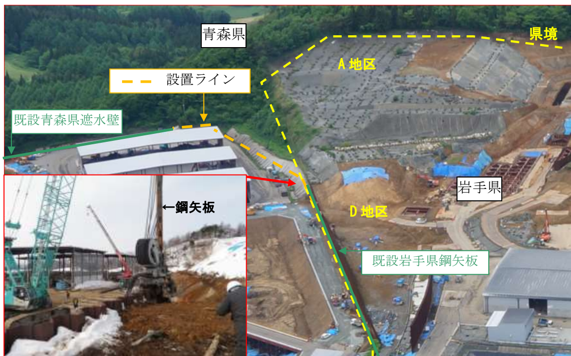
遮水工現況写真 (H26.3.4)
