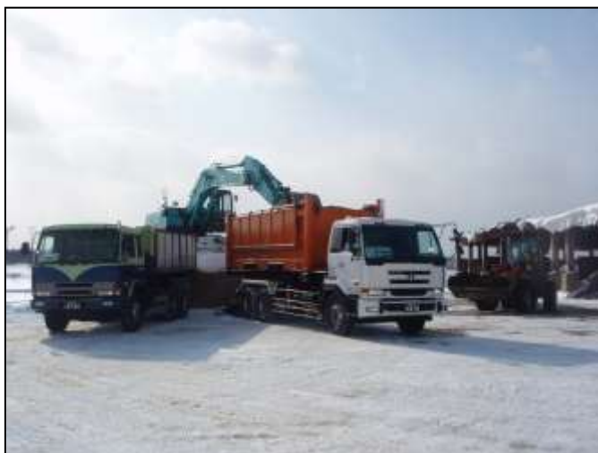
【廃棄物積込状況 H26.2.14】
