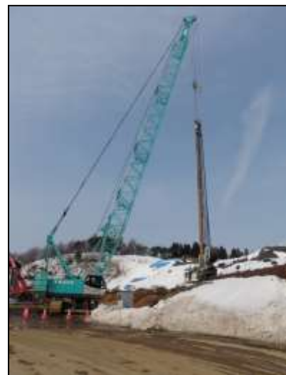
【鋼矢板設置状況 H26.3.4】
