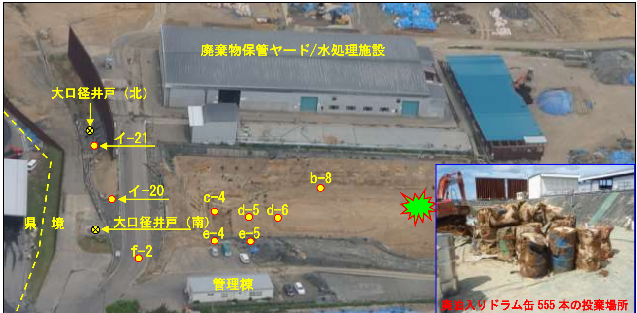
図-2 N地区現況写真 (H25. 6. 6)
