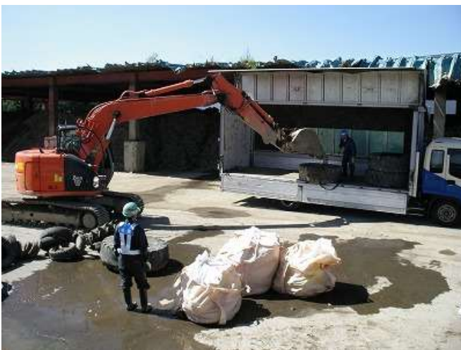
【廃タイヤ積込状況】
