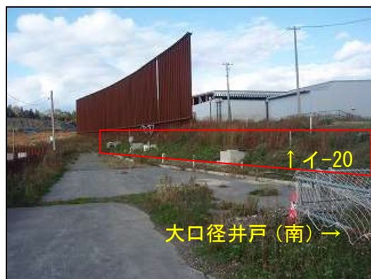
写真：イ-20周辺部の遮水シート撤去（□部分）
