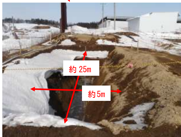
道路舗装除去、貯水池設置状況（H27.2）
