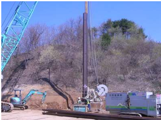
クラッシュパイラー工法 (5/1)
