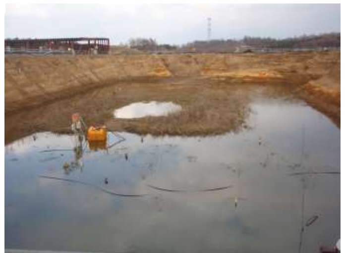
【図4 N地区の現況写真（H26.4.22）】
