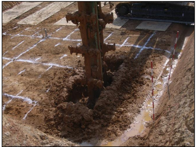
図6 パワーブレンダーによる原位置フェントンエ
