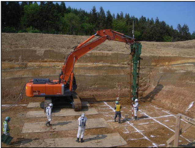
図6 パワーブレンダーによる原位置フェントンエ
