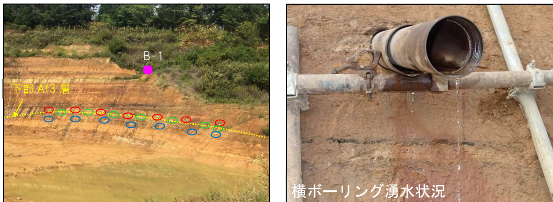
図5 AB地区境界部横ボーリング設置状況
