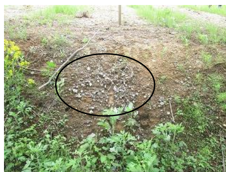
排水性向上のため設けた砂利層
