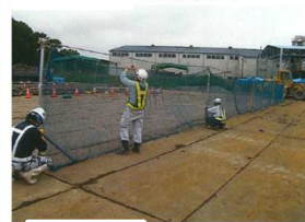
重機離隔ネット
