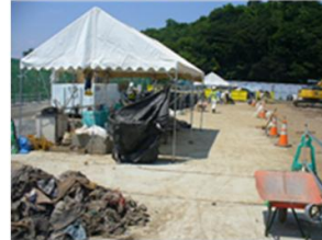
敷鉄板の着色
