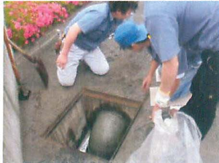
工場最終排水溝（分離層）の清掃
