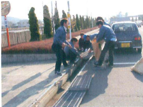
雪解け後の春の構内外清掃活動 構内の排水側溝の泥上げ清掃
