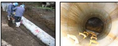
雨水配管：工場内に降った雨水を集めて流す配管です。
