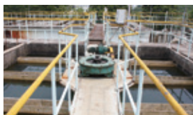
当公司が設置・運営する設備で水を浄化し地域に供給
