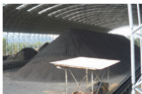
石炭置場屋根新設工事後
