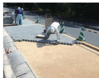
車道用ブロックの試験舗装
