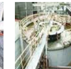
活性汚泥処理設備 有機物をバクテリアで分解して除去します。
