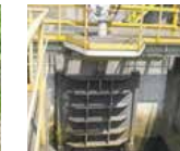
排水遮断ゲート 万一のトラブル時に排水を遮断します。
