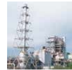
湿式脱硫設備 湿式脱硫法により、排ガス中のSOx(硫黄酸化物)を除去します。
