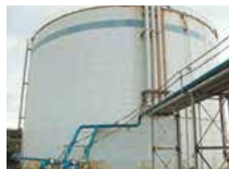
雨水タンク(散水用) 雨水をも無駄にすることなく、散水用に有効活用します。
