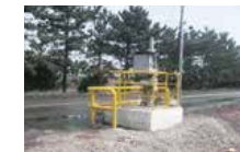
排水自動監視装置 排水の水質を自動で監視します。
