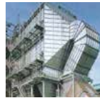
電気式集じん機 燃焼過程で発生するばいじんをその性状(粒径分布・排ガス中濃度等)に応じて、2種類の集じん機(電気式/バグフィルター式)を使い分けて捕集しています。
