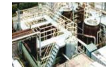
ろ過設備(2次処理) 処理した排水中に残る不溶解成分を砂の層でろ過し除去します。
