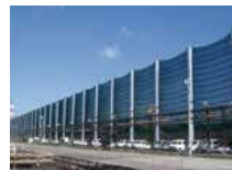
ヤード防風ネット 防風ネットの設置により風速を弱めて、原料の飛散を抑制します。
