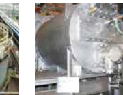
低NOxリジエナバーナ NOxの生成を抑制し省エネも実現できるバーナーを採用しています。
