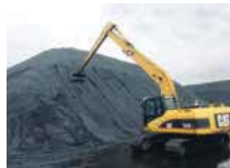
石炭ヤードの填圧作業 石炭の山の表面を押し固めて、石炭の飛散を抑制します。
