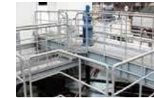
加圧浮上設備 油分を泡の力で浮かせて除去します。
