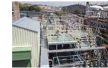
排水凝集沈殿処理設備 細かな不溶解成分を薬剤で大きな塊に集めて沈めることにより除去します。
