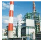
活性コークス式乾式脱硫脱硝設備 活性コークスを用いた乾式脱硫脱硝法により、排ガス中のSOx(硫黄酸化物)・NOx(窒素酸化物)を除去します。
