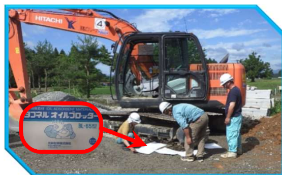
③ 油吸着マットで油流出の拡大を防止
