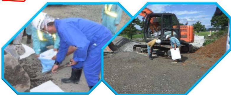
⑤ 油汚染された油吸着マット等を回収及び最終確認
