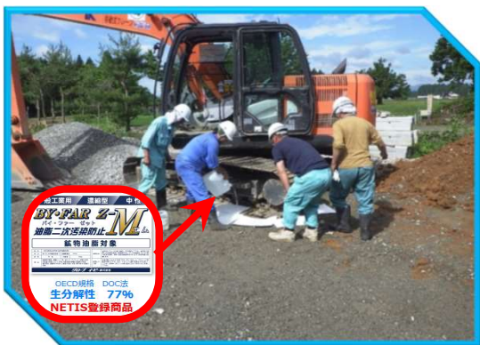
④ 油分解洗浄剤による中和作業
