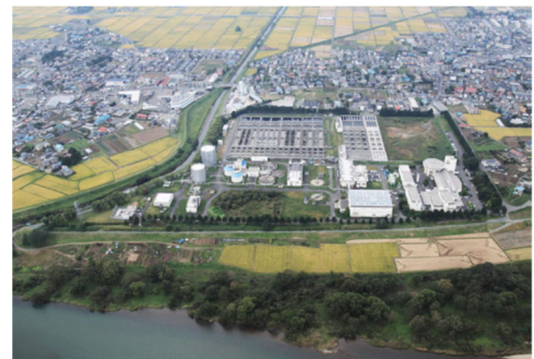
都南浄化センター
