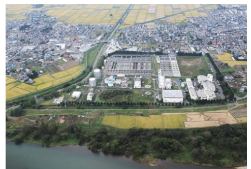
都南浄化センター
