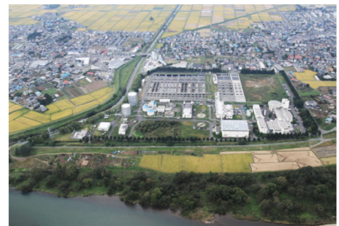
都南浄化センター
