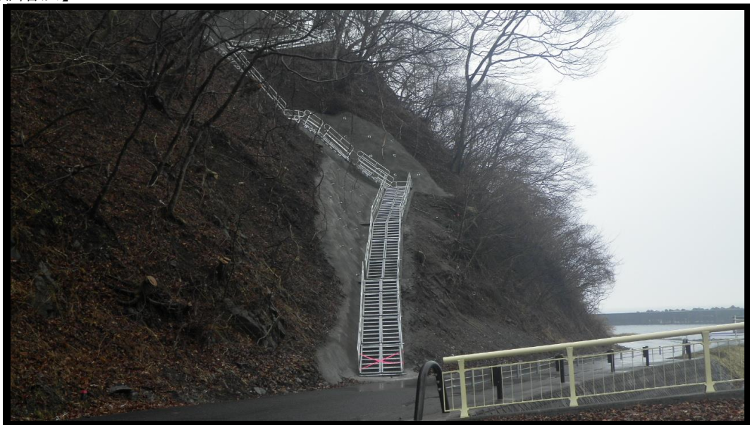
【堀内地区避難階段】
