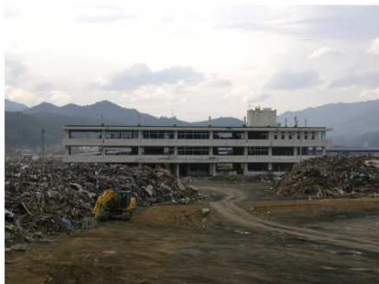
被災後の気仙中学校の南面(運動場は震災直後に工事関係場として利用)。
