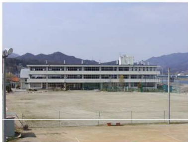
被災前の気仙中学校の南面と運動場。
