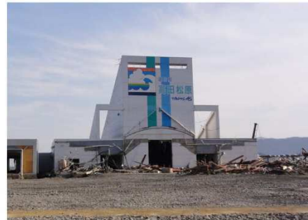
被災後のタピック45*
