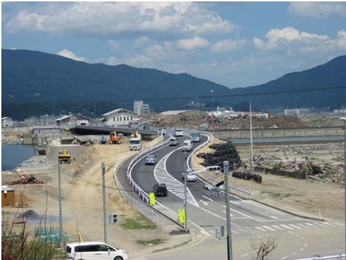
陸前高田市での仮橋復旧
