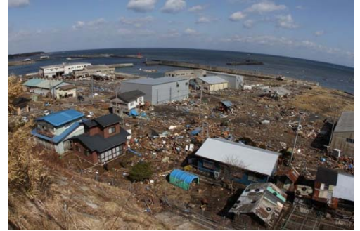
洋野町における津波来襲の様子
