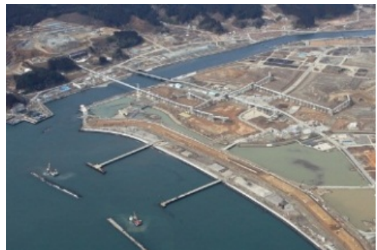
上空から見た公園予定地(平成27年3月 岩手県撮影)
