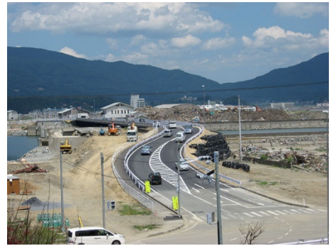
陸前高田市での仮橋復旧
