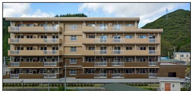
釜石市野田地区（H25. 10. 17 完成）
