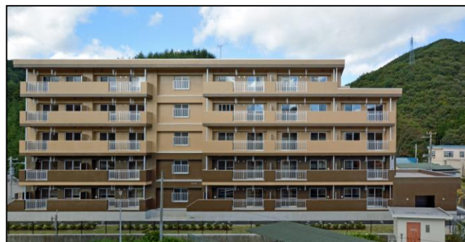
釜石市野田地区 (H25. 10. 17 完成)
