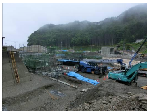
復旧工事中の三陸鉄道北リアス線
