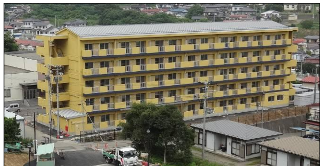
大槌町吉里吉里地区（H25. 8. 19 完成）
