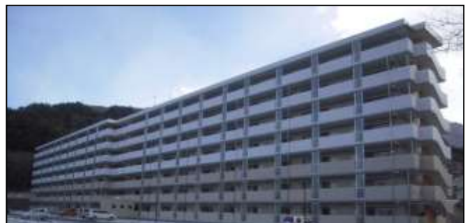
19 釜石市平田地区（H26. 1. 24 完成）
