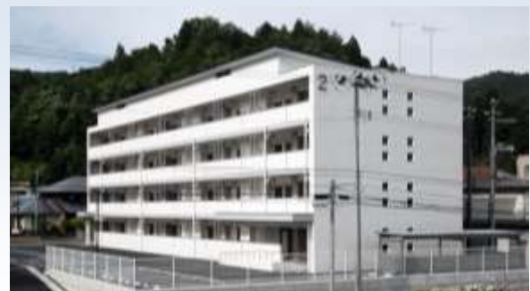
宮古市西町地区 (H27.6.5完成)
