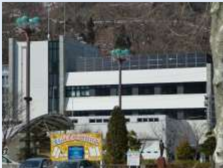
(釜石市：消防署庁舎の太陽光発電)
