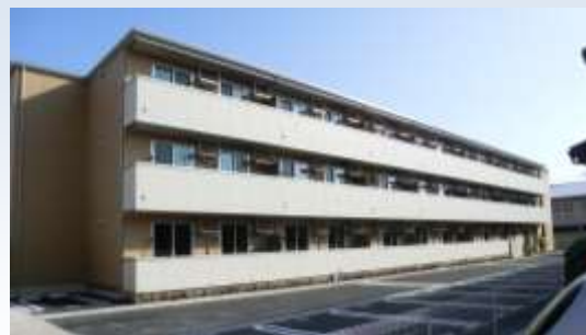
宮古市宮町地区 (H27.3.25完成)
