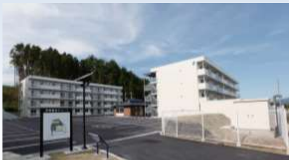
山田町妻の神地区 (H27.10.21完成)
