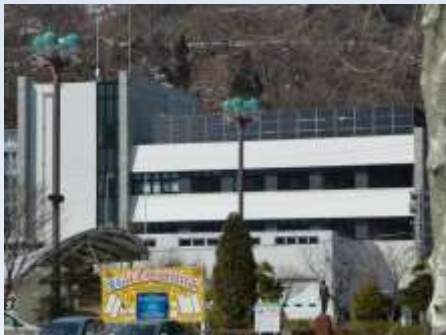
(釜石市：消防署庁舎の太陽光発電)
