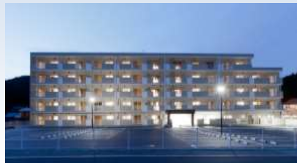
宮古市八木沢地区 (H27.10.27完成)
