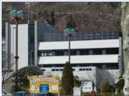
(釜石市：消防署庁舎の太陽光発電)
