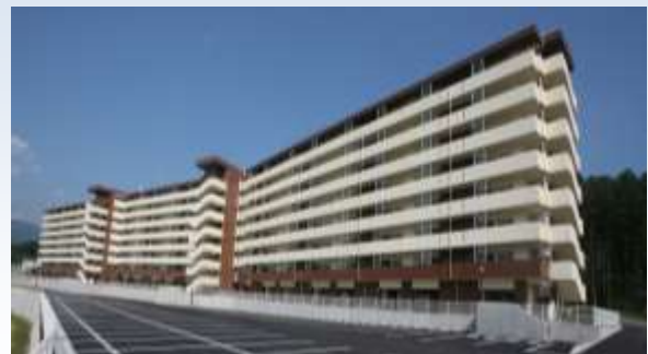
陸前高田市中田地区 (H27.9.25完成)
