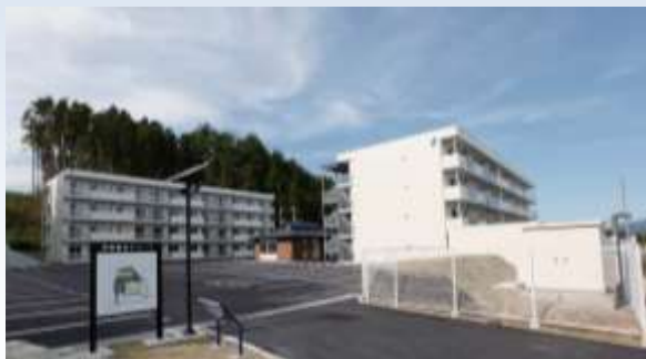
山田町妻の神地区 (H27.10.21完成)
