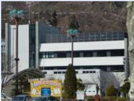
(釜石市：消防署庁舎の太陽光発電)
