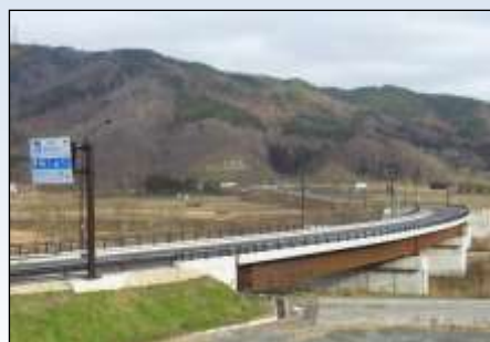
一般県道遠野住田線新里工区供用 （H27.12.5 遠野市）
