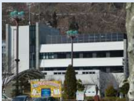
(釜石市：消防署庁舎の太陽光発電)
