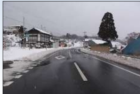
一般国道340号「泥ノ木」供用 (H27.1.16 九戸村)
