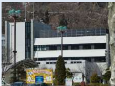
(釜石市：消防署庁舎の太陽光発電)
