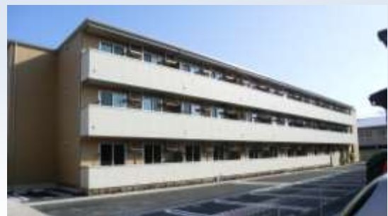
宮古市宮町地区 (H27.3.25完成)
