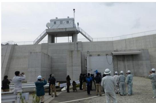
平成29年4月、<sup>あつたり</sup>合足農地海岸(大船渡市)で、津波注意報等を受信して自動的に水門等を閉鎖する「水門・陸こう(※)自動閉鎖システム」の試験運用を開始した。
