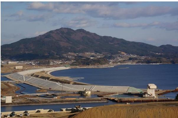
平成28年12月、延長約2kmに及ぶ高田海岸防潮堤の復旧が概成した。浸食を防ぐための第1線堤（海側）は原型復旧、津波を防ぐための第2線堤（陸側）は、被災前T.P（※）+5.5mの高さからT.P+12.5mに嵩上げ復旧した。
