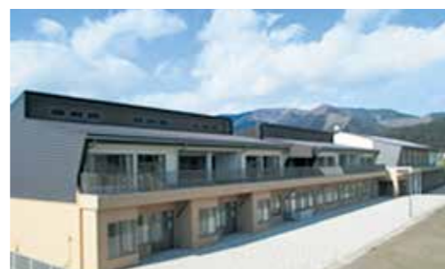
大船渡市立赤崎小学校(平成29年3月竣工)
