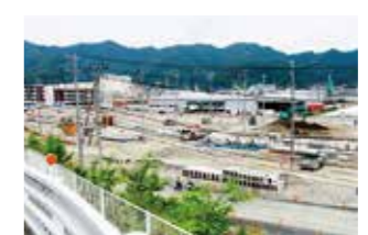
金石市嬉石・松原地区土地区画整理 (平成29年6月)
