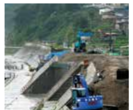
久慈市久喜漁港海岸災害復旧工事(平成25年9月)
