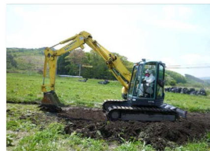
【写真4: 重機による除礫(参考)】
