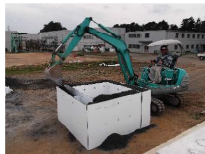
バックホウ等で L-box に 汚染のない土砂を充填する
