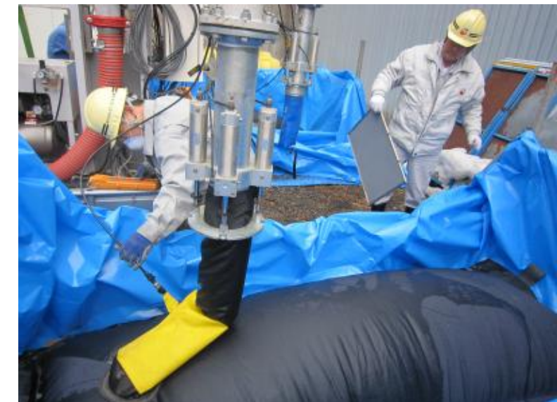
写真 2 袋詰充填工実施状況
