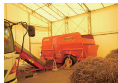
前処理施設（裁断機）の整備
