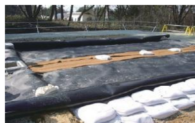
道路側溝汚泥一時保管場所(奥州市)
