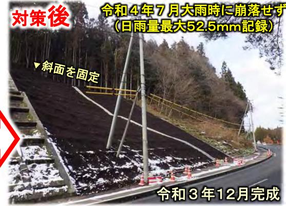
対策の 効果 崩落していた道路の斜面を、大雨時でも崩壊しないように枠で固定し、 通行止めとなるリスクを低減しました。
