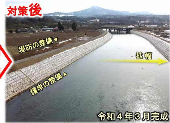
対策の 効果 平成25年9月の大雨での被害を受けて、 再度の災害が生じないよう、堤防の整備や河道の掘削を実施しました。
