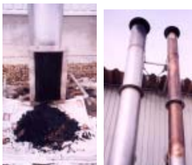
煙突に付着したスス(左)と異常燃焼で焼けた煙突(右)
