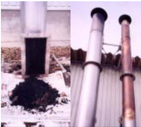
煙突に付着したスス(左)と異常燃焼で焼けた煙突(右)
